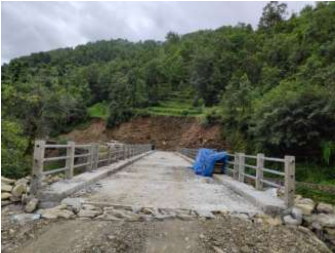
निर्माण सम्पन्न पाखर खोला पुल
