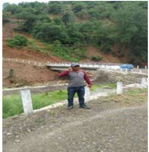
निर्माण सम्पन्न सिपा खोला पुल
