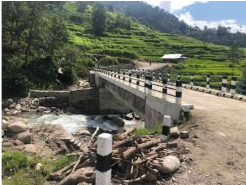
चर्नावती खोला पुल
